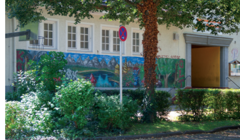
Eingangsbereich der zum Jugendzentrum umgebauten Alten Schule am Grünen Markt, 2014
